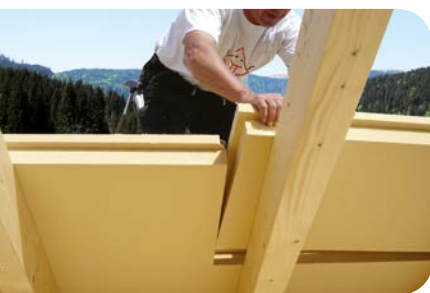
Colocación directamente por encima del cabio
