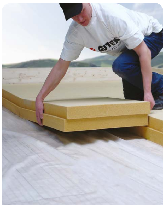
Colocación de GUTEX Thermoflat
