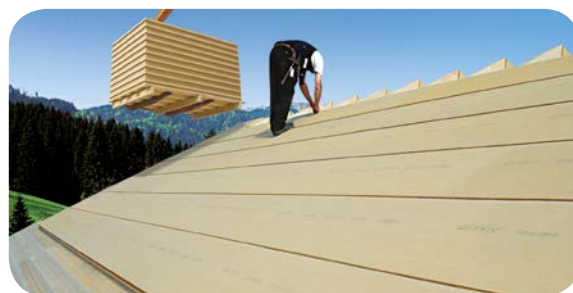
Bajo-teja como cubierta provisional hasta 12 semanas frente a la intemperie
