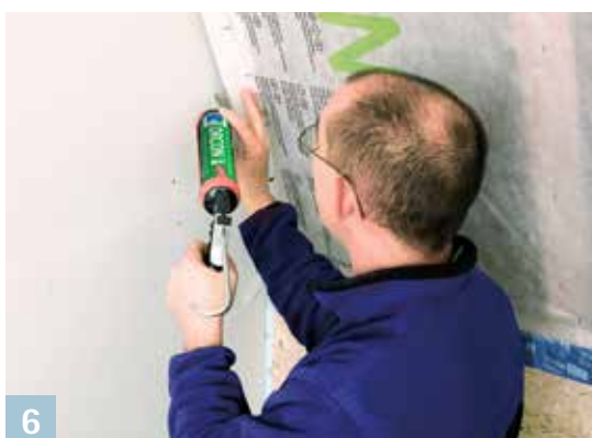
ORCON F Adhesivo universal de unión en cartucho para uniones con elementos colindantes minerales o de superficies rugosas.
