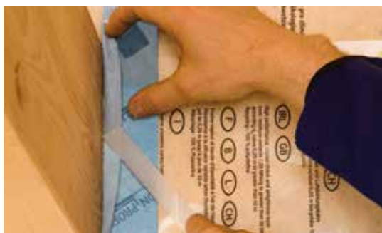
KAFLEX / ROFLEX Traspaso seguro y duradero de tubos y cables
