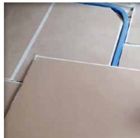
PhoneStar 25 - como recrecido y plano de conducción de instalaciones
