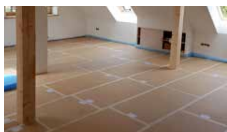
Acondicionamiento de un desván PhoneStar colocado en una única capa
