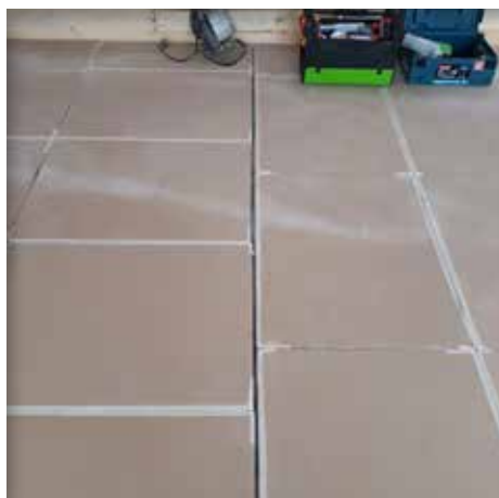
PhoneStar 25 - como capa pesada en forjados
