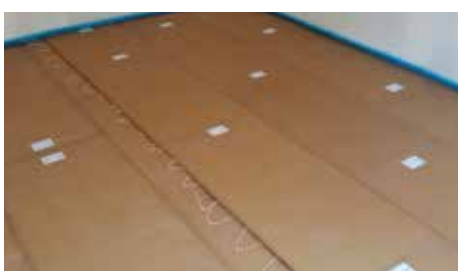
Fabricación de módulos - PhoneStar en varias capas encoladas
